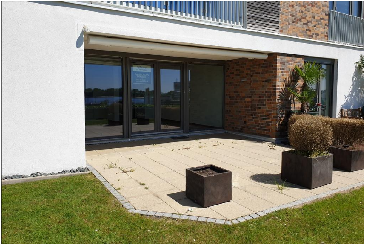
Große Südterrasse mit elektrischer Markise und Infrarot-Heizstrahler
